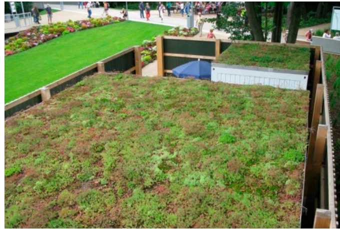
Extenzivní střešní zahrada na kontejnerových budkách
